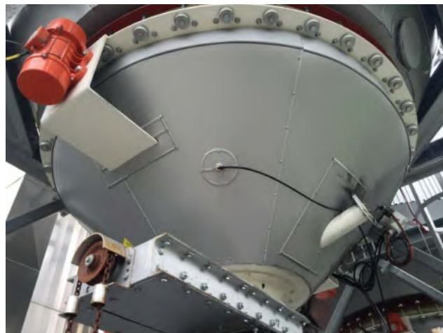
Installation d'un fond vibrant dans le domaine du recyclage
