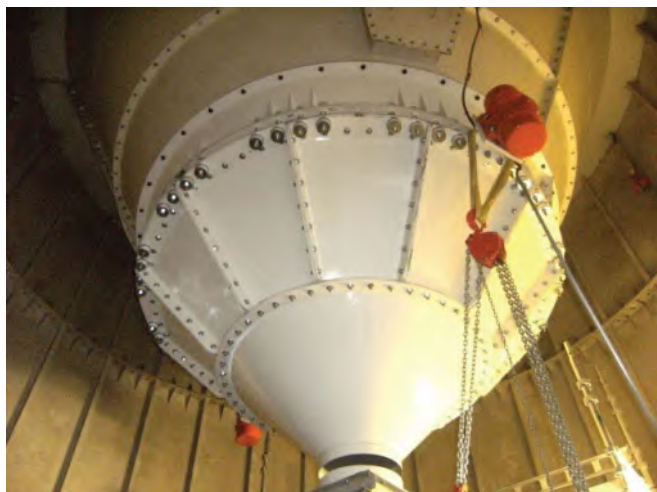
Installation d'un fond vibrant dans le domaine de l'alimentation pour poisson
